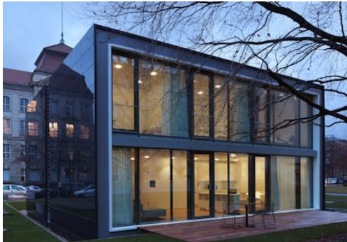
Leitprojekt Effizienzhaus Plus mit Elektromobilität
